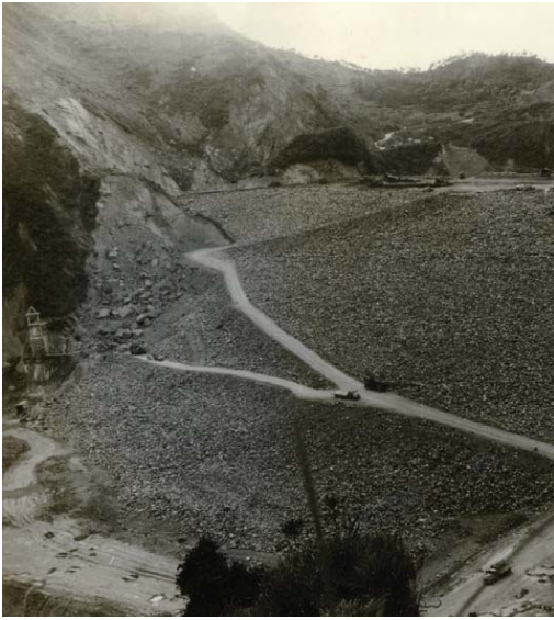
52年5月石門大圳進水口完工照片
