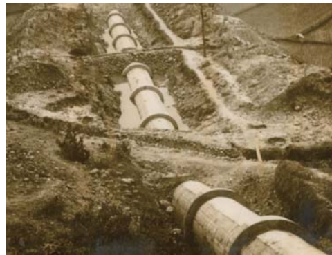
49年4月石門大圳第四 工區平鎮倒虹吸管工程
