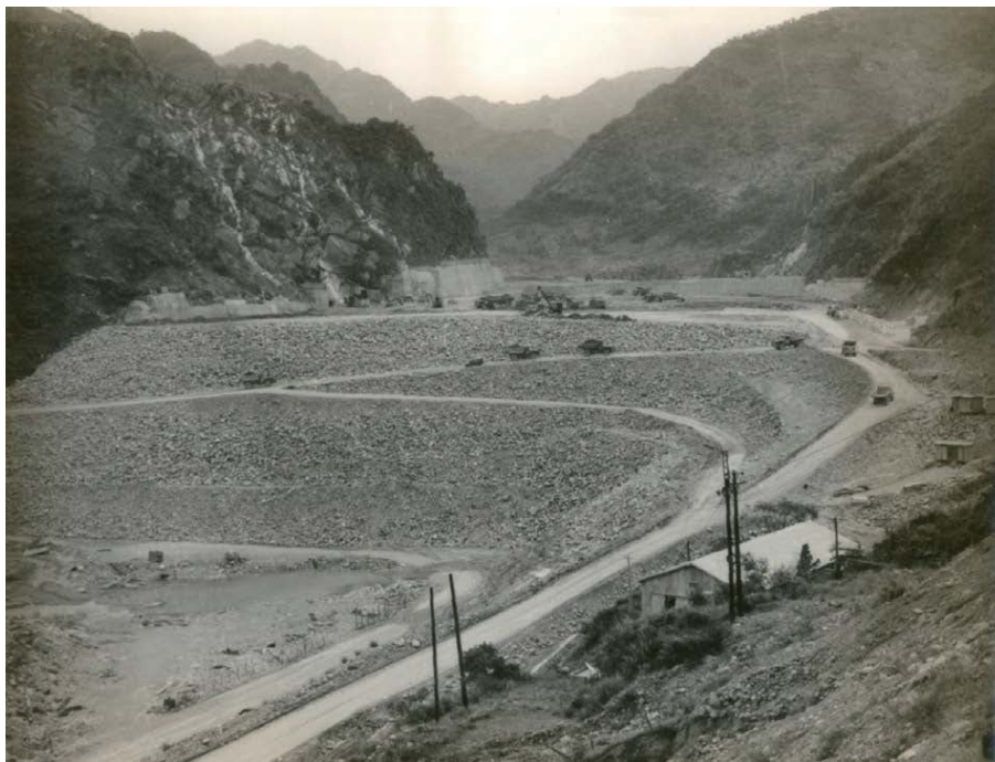
51年8月大壩填築施工情形;大壩外側的施工道路， 隨大壩填築逐步升高，最後整合為聯絡道路
