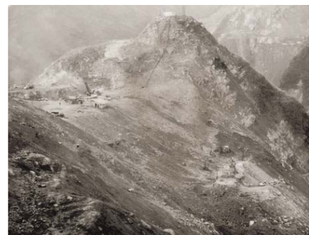
50年1月溢洪道基礎完成開挖
