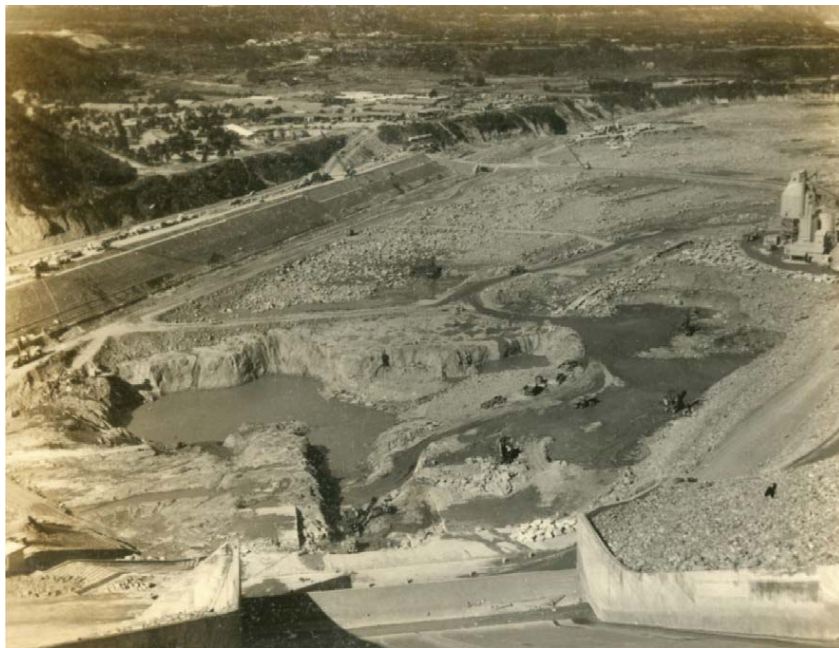
52年葛樂禮颱風侵襲對後池造成嚴重破壞，災後經由地形測量，發現池底平均高程約達105公尺，與水工模型試驗結果，竟然相當吻合，洩洪雖然破壞了後池，卻也宛如替石門水庫進行了一次「全尺寸水工試驗」
