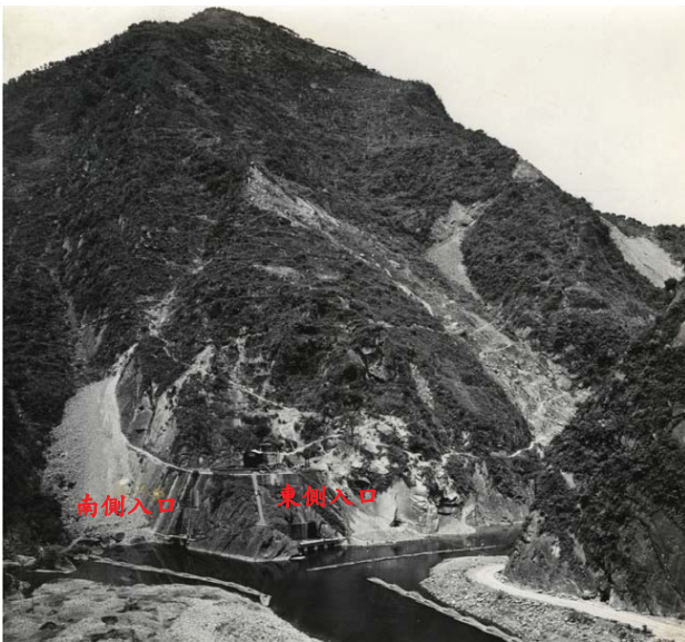
原桃園大圳進水口有兩個入口，由於位於石門大壩位置，故施工時須封閉進水口
