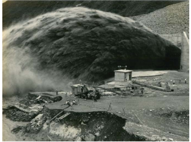
9月12日葛樂禮颱風溢洪道洩洪及電廠尾水道圍堤沖損情形
