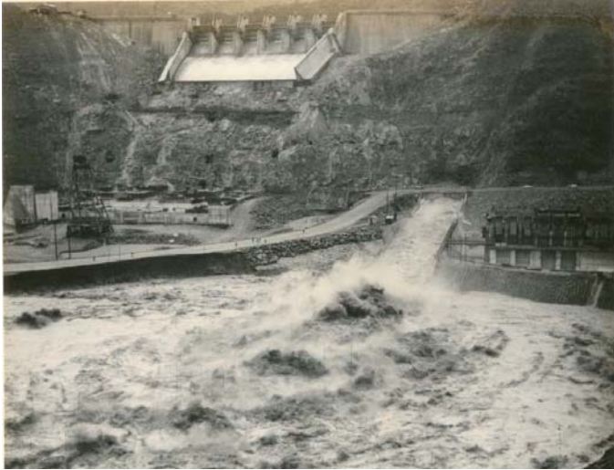
51年9月愛美颱風導水隧道排水情形
