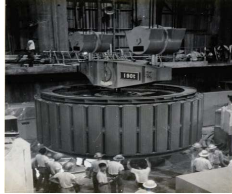
52年7月電廠二號發電機轉子安裝
