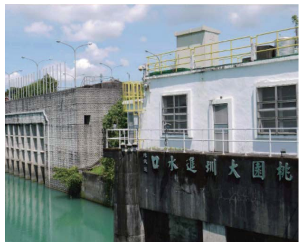
新建位於後池末端左側的桃園大圳進水口現況
