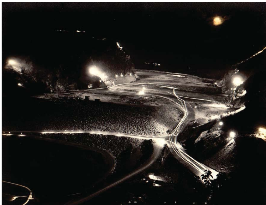
51年8月大壩填築施工；外側的施工道路， 隨大壩填築逐步升高，最後整合為聯絡道路
