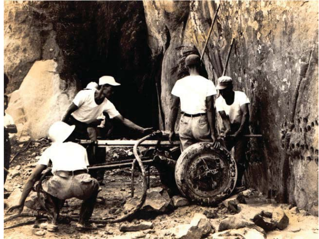
48年6月美國莫克(MK)公司指導 訓練施工人員學習岩石鑽孔機
