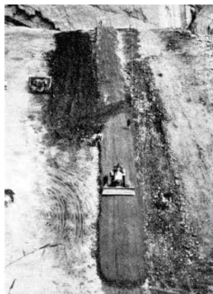
副壩之滾壓混凝土（RCC）施工情況；滾壓混凝土施工時，以推土機平鋪成厚度50公分的混凝土層，再予以推土機自重滾壓，並在每一層施工前，澆置水泥砂漿，以確保每層之間緊密結合。RCC工法施工，可排除天候因素干擾，加快工程速度
