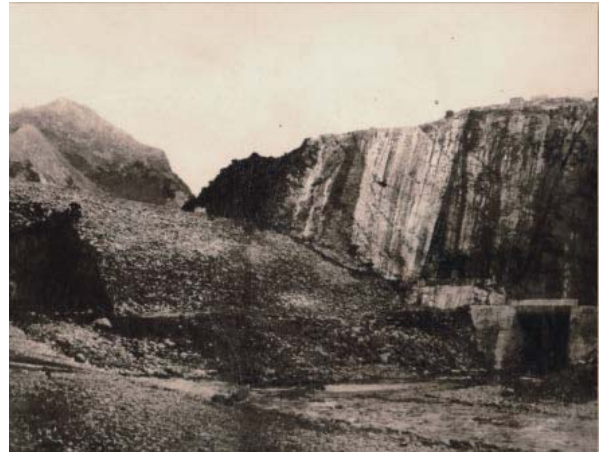
50年7月副壩上游面；當時副壩已填至標高190，照片右側為導水隧道入口
