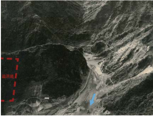
溢洪道施工前，由下游側空拍右山脊照片
