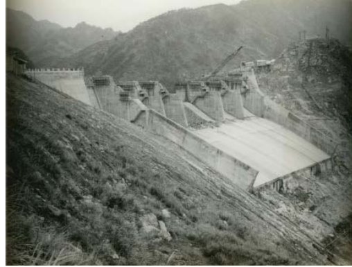
51年4月溢洪道上半部及溢洪堰接近完成
