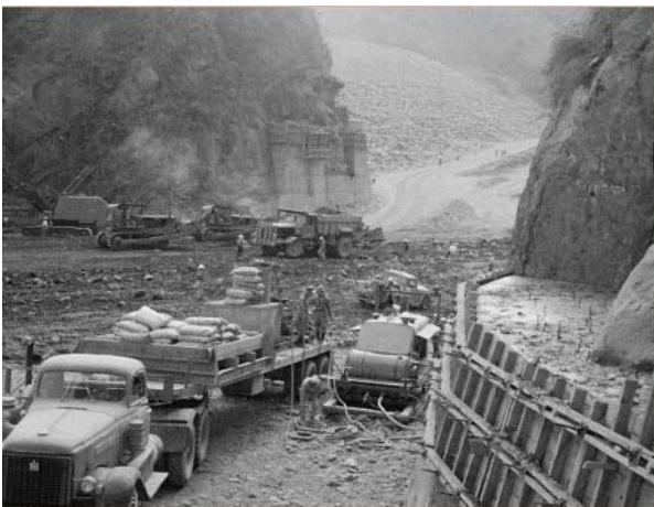
大壩主體工程施工情形，遠處為上游擋水壩
