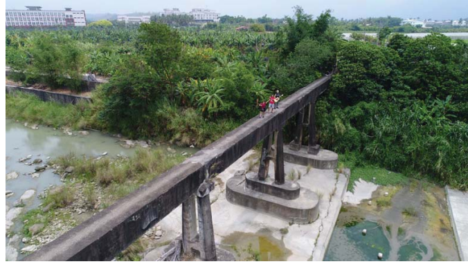
二層行溪埤圳圓潭仔隧道現況，現成為旗山圳水橋 (出處：〈旗山圳生生不息，川流旗山百餘年！〉《公民新聞》，2018年9月26日 https://www.peopo.org/news/379421 )
