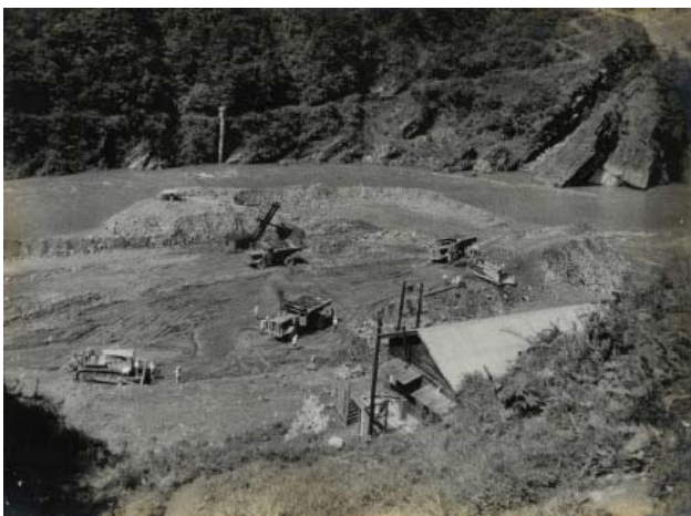
民國48年6月上游擋水壩施工初期情形；遠處河水尚未斷流
