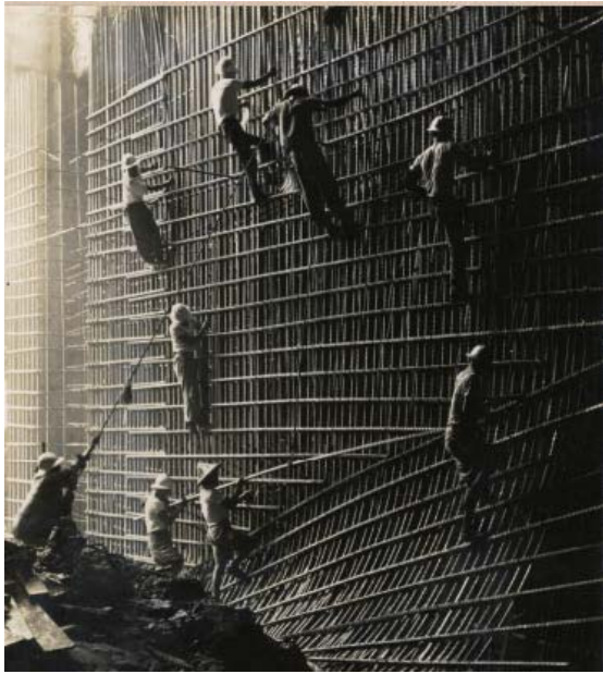
48年8月導水隧道入口段鋼筋細紮情形
