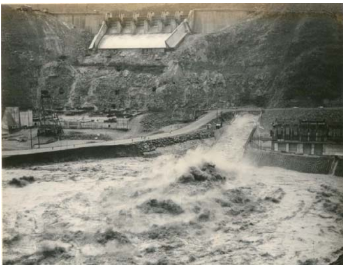
51年9月愛美颱風導水隧道排水情形
