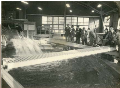
國內外專家於臺北水工試驗室(現改制為臺灣大學水工試驗所)視察正在進行之溢洪道水工模型試驗 模型比例尺為1:60
