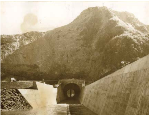
49年12月導水隧道出口導槽完工照片
