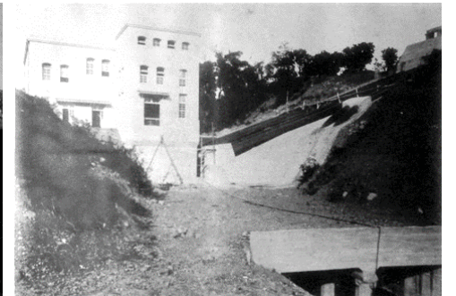
竣工不久之土壟灣發電所
