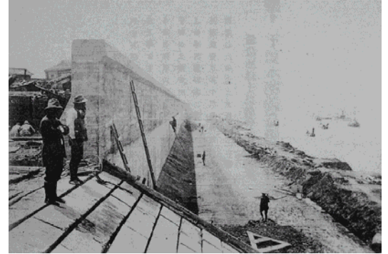
以原大稻埕石砌護岸為基礎興建的大稻埕RC造防洪牆式堤防完工舊照
