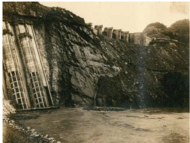
51年9月愛美 (Amy) 颱風侵台，上游擋水壩蓄洪情形 當時取水塔已大致完成，水位已接近發電進水口
