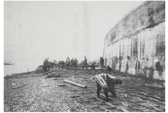
艋舺RC造防洪牆式堤防及串磚沉床施工舊照
