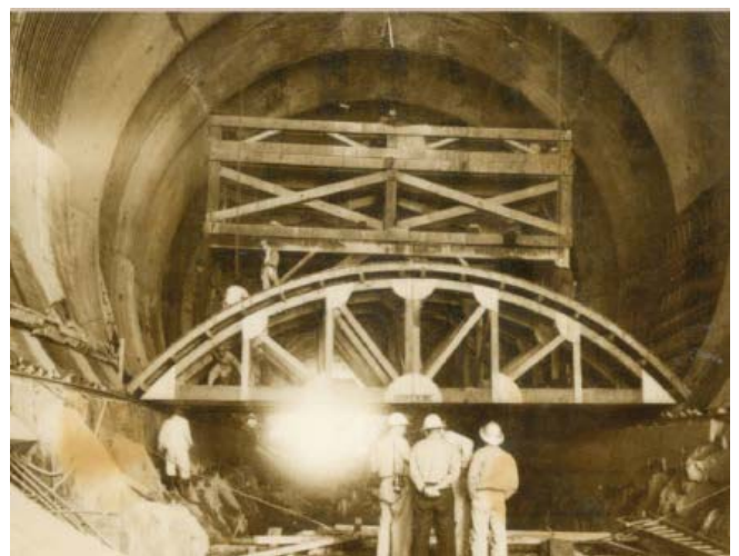
48年12月導水隧道頂拱混凝土模型架作業情形
