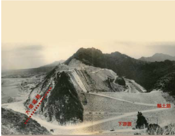
50年6月擋水壩下游側完工照 擋水壩的填築材料都是河床卵礫石 因為河道轉彎，故副壩壩軸與大壩壩軸不一致
