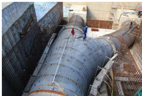
將電廠二號發電鋼管改為排砂專用管
