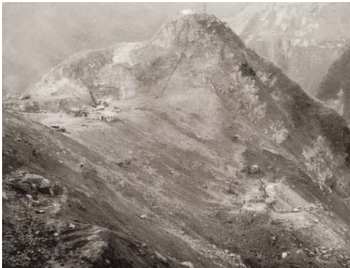
50年1月溢洪道基礎完成開挖 原地形頂部標高約285公尺，開挖60 公尺，形成一U型缺口
