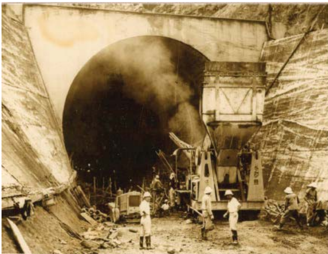
48年10月導水隧道混凝土澆置情形
