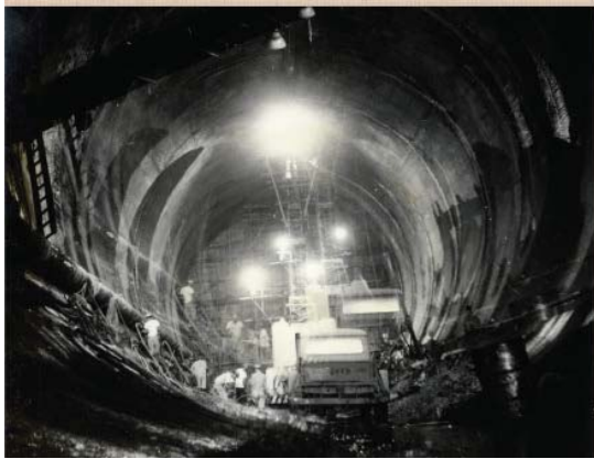
52年6月導水隧道永久封堵段趕工 全部導水隧道封堵工作費時4個半月
