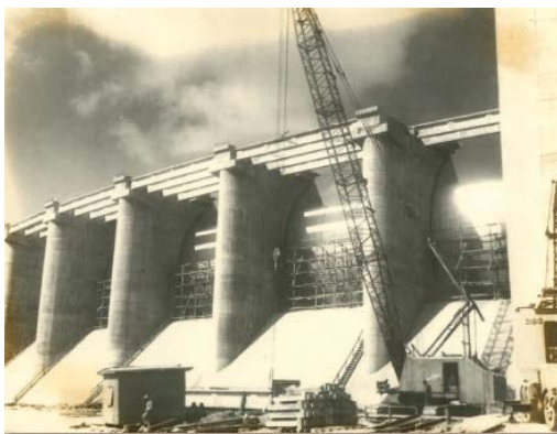
51年11月溢洪道橋之預力樑吊裝作業
