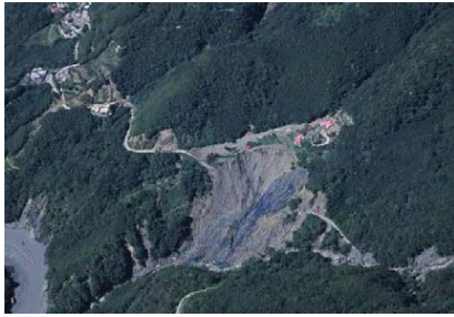
集水區大面積崩坍
