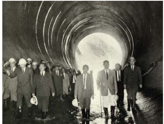
49年12月導水隧道通水前履勘，人員包括石門水庫建設會執行長徐鼎及總工程師顧文魁
