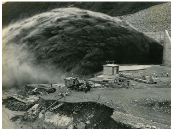
葛樂禮颱風溢洪道洩洪及電廠尾水道圍堤沖損情形
